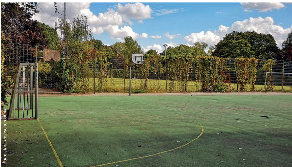
Der Erhalt und die Instandsetzung von Bolzplätzen ist der zentrale Wunsch von Jugendlichen. In einem schlechten Zustand ist auch der Sportplatz am U-Bhf. Halemweg.
