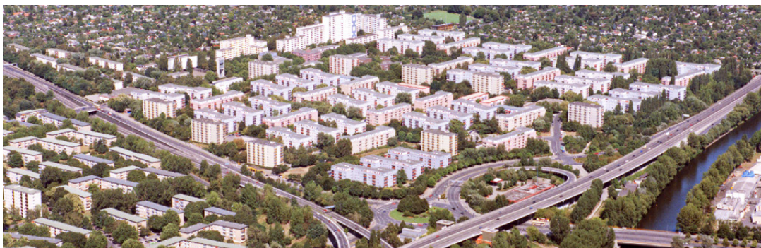
Luftbild von der Paul-Hertz-Siedlung, August 1998: Die Aufstockungen sind abgeschlossen.
