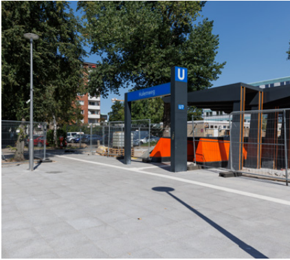
Frisch gepflastert: U-Bahnhof Halemweg
